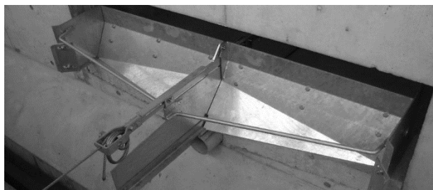
图5 日式V形刮板
