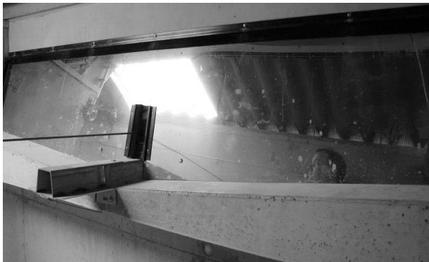
图9 刮粪地沟盖板
