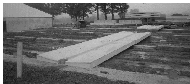
图8 混凝土预制沟底
