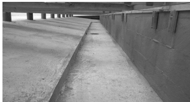
图3 带坡度分娩舍地沟
